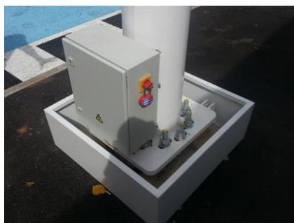
Ce coffret est un organe de sécurité des matériels qui permet d'isoler électriquement la nacelle lors de régime fortement venté. Il contient également, le dispositif parafoudre.
